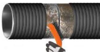
Перед нанесением манжеты, зона сварного стыка и примыкающая заводская изоляция должна быть очищена от ржавчины, пыли, грязи, краски, остатков старой и поврежденной изоляции, масляных пятен (при необходимости использовать подходящий растворитель).
