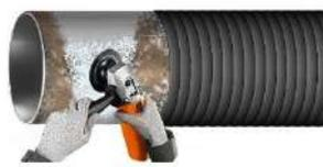
Le nettoyage de la surface métallique se fait à la main à l'aide d'une brosse métallique et d'outils électriques (ISO 8504-3). À la suite du nettoyage, l'état de la surface doit être min. St3 (ISO 8501-1). Une fois le nettoyage terminé, la surface doit être protégée de la poussière et de l'humidité. Pour obtenir la plus grande efficacité, la préparation de la surface doit être effectuée immédiatement avant l'application du système anticorrosion.
