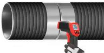
La température de chauffage du joint en différents points est surveillée avec un pyromètre pour s'assurer que le tuyau est chauffé sur toute sa circonférence.
