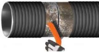
Avant d'appliquer le manchon, la zone du joint soudé et l'isolation d'usine adjacente doivent être exemptes de rouille, de poussière, de saleté, de peinture, de restes d'isolation ancienne et endommagée, de taches d'huile (si nécessaire, utilisez un solvant approprié).
