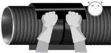
Placez le manchon sur le cordon de soudure, aligné au centre. Enroulez sans serrer le collier autour du tuyau, en assurant le chevauchement requis. Dans ce cas, le manchon doit s'affaisser au bas du pipeline. Superposez les extrémités du manchon entre les positions « 10 » et « 2 heures ». Appuyez fermement sur la couche inférieure du manchon dans le chevauchement.
