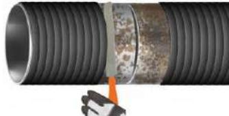
Coupez les bords de l'isolation d'usine à un angle de 30 °. Poncez l'isolant d'usine autour de la circonférence avec du papier émeri grossier jusqu'à ce qu'il soit rugueux. Retirez la poussière de ponçage.
